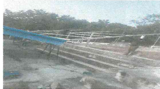
ESTRUCTURA Y COLOCACION DE ENTECHADO
