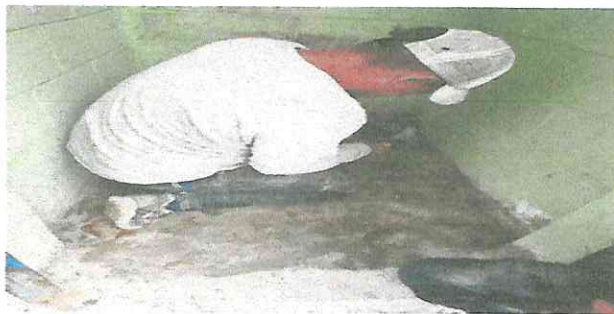
COLOCACION DE PISO Y BAÑOS
