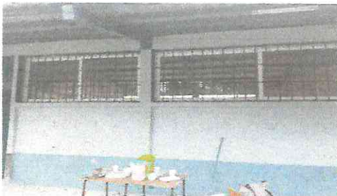
PINTADO Y LIJADO DE PUERTAS, BARRAMDAS Y VENTANAS PVC
