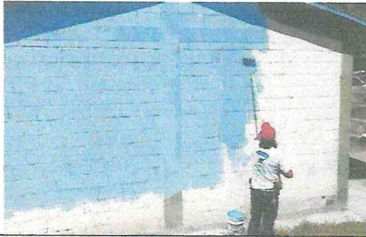
PINTURA INTERIOR Y EXTERIOR
